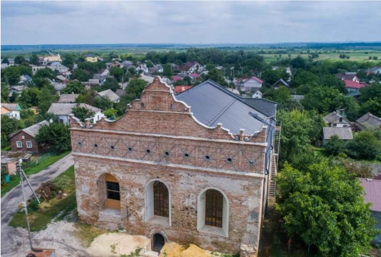
Синагога Острога у процесі реконструкції
